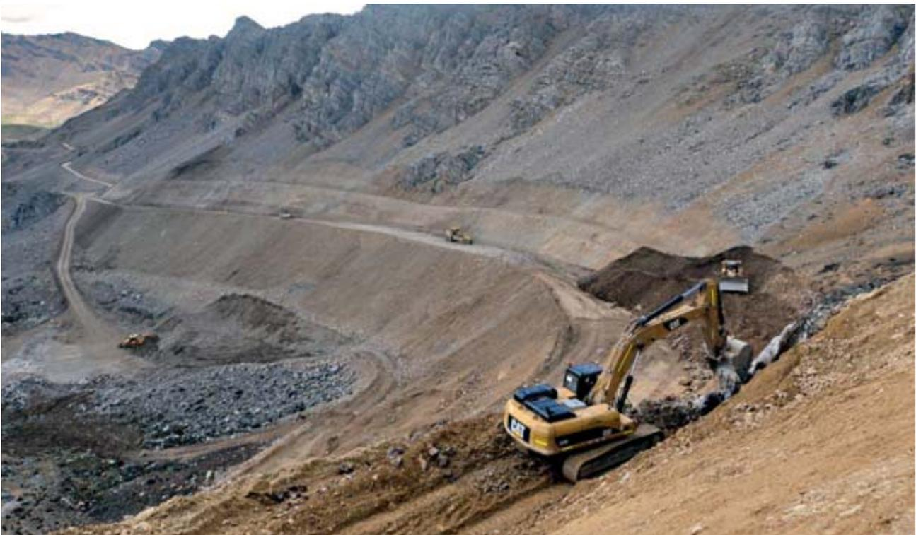
Desde enero de 2012, ICCGSA asumió la ejecución de diferentes obras para la Minera Chinalco Perú en su proyecto Toromocho. Entre los trabajos encargados está la construcción de accesos, conformación de terraplenes y plataformas para la mina.
