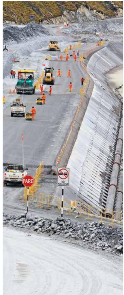
Para terminar las obras preliminares a la construcción de la Fase V, ICCGSA realizó el desbroce y compactación del espaldón de la presa entre las cotas 3,985 y 4,110 msnm, efectuando trabajos de movimiento de tierras y relleno del espaldón colocados en capas de 1 metro, con material 3B de la mina. Asimismo, se construyó la rampa de ingreso al espaldón de la presa.
