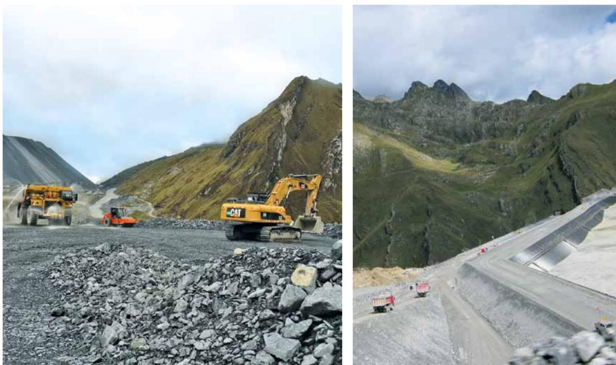
El 16 de setiembre de 2013, la Compañía Minera Antamina encomendó a ICCGSA el relleno y compactación del espaldón de su presa de relaves, como parte de la construcción de la Fase V de esta estructura.
