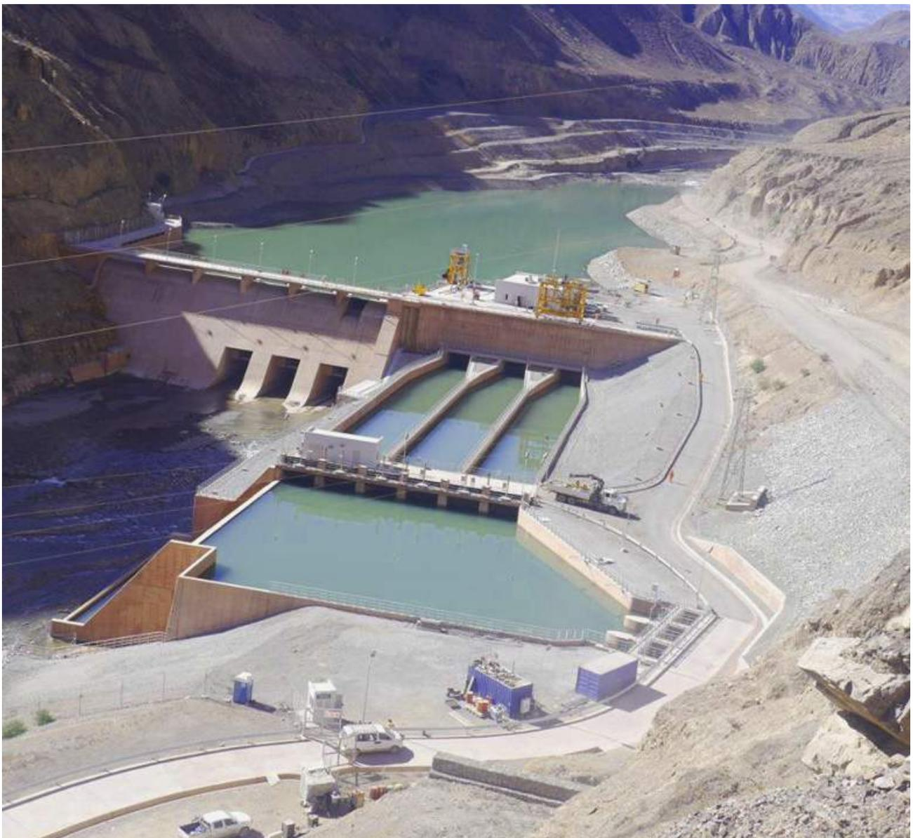
►►► Presa Cheves de Regulación Diaria vista de aguas abajo, incluye el Desarenador de 3 Naves y Cámara de Carga. También se aprecia el espejo de agua del embalse.
