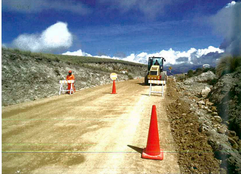
El proyecto consistió en el mejoramiento del camino Cusco Las Bambas específicamente entre las localidades de Paruro y Ccapacmarca.
