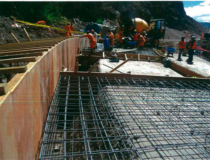
Se procedió a hacer el enrocado para el ensanche de plataformas.
