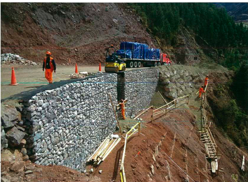
A lo largo del tramo se han construido 755 m 3 de gaviones.
