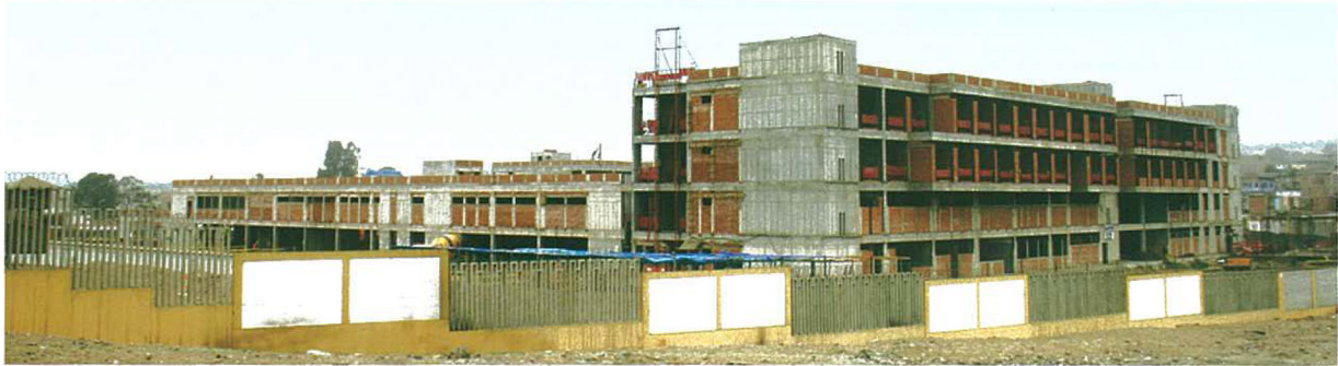
Vista general desde la avenida 200 Millas.
